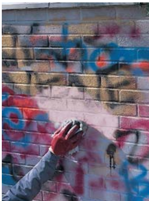
Veeg graffiti weg van een poreuze ondergrond met een beschermlaag van Antigraffiti-coating
